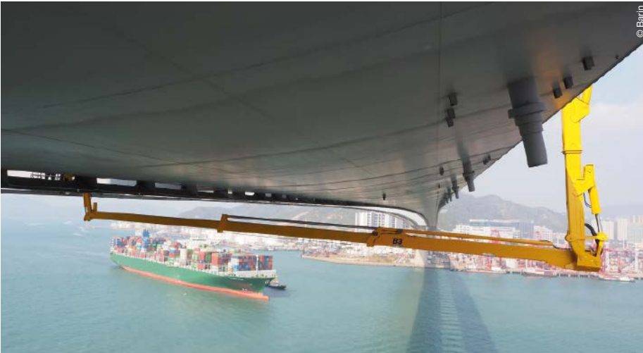
Barin-Arbeitsbühnen ermöglichen auch in Hongkong die sichere Brückeninspektion von unten, hier an der Stonecutters Bridge.
