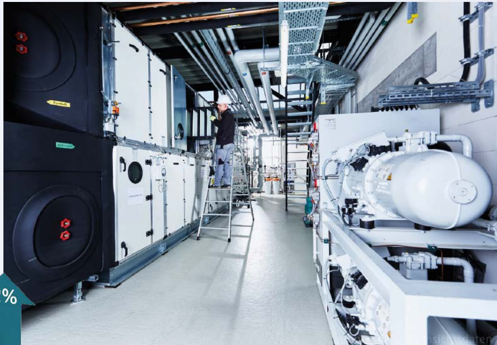
Aktuell wird die Kälteanlage modernisiert und künftig mit dem CO 2 -freundlicheren Kühlmittel R290 Propangas betrieben.
