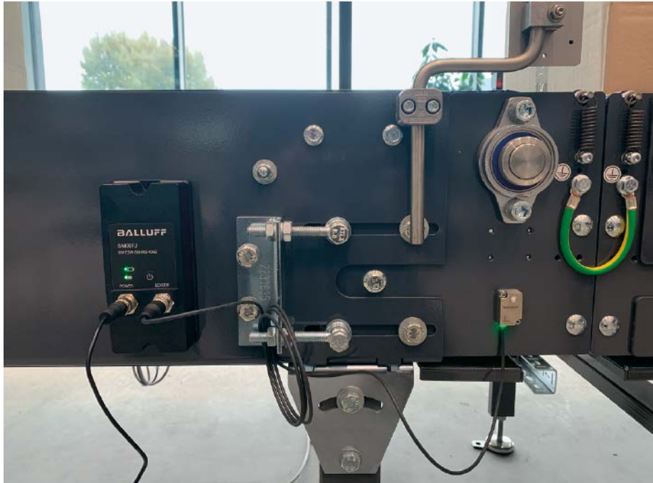
Balluff unterstützt die Idee von Plug & Produce mit dem multifunktionalen Condition-Monitoring-Sensorsystem. Hier zu sehen die Testinstallation am SIPBB.
