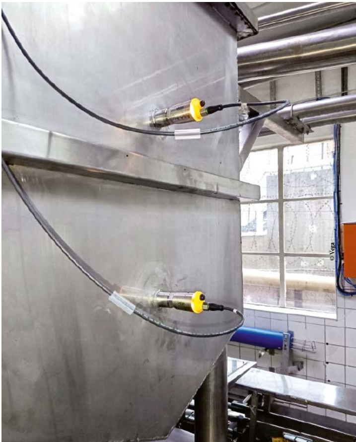
Der Vegapoint 21 wurde in der Abfüll-/Verpackungsanlage seitlich montiert und erfasst High-/Low-Füllstände.
