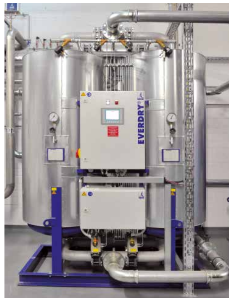
Der Drucklufttrockner Everdry ermöglicht die zuverlässige Abfallsortierung im Recyclingbetrieb.
