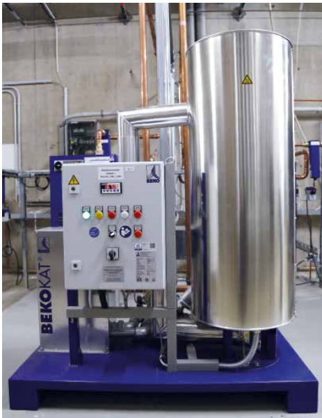
Der katalytische Konverter Bekokat entölt die Druckluft, die die Inspektionskameras bei einem Kaffeeröster vor Verschmutzung schützt.
