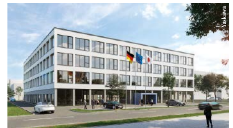
Yaskawa-Gebäude in Hattersheim
