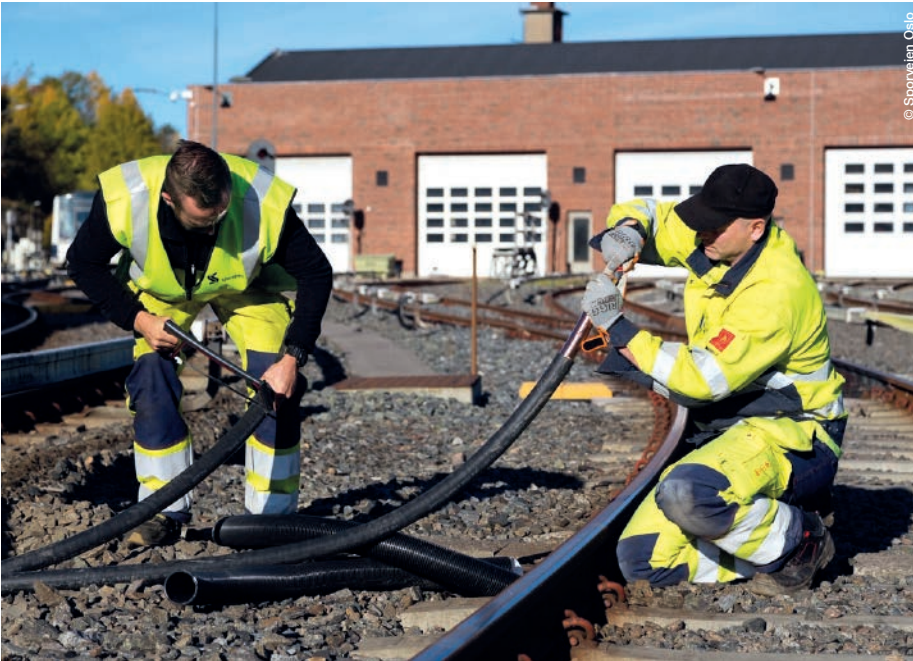
Das speziell entwickelte Kabel hält auch den norwegischen Minustemperaturen stand.
