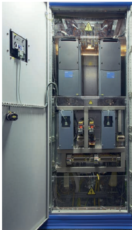
Vier Umrichtereinheiten mit je 730 A und zwei große mit je 1.640 A sorgen für die Ansteuerung der Spezialmotoren. Atesteo entschied sich für diesen Aufbau, weil sie damit sehr flexibel je nach Leistung des angeschlossenen Motors die kleinen Umrichter einzeln oder zwei parallel schalten können.
