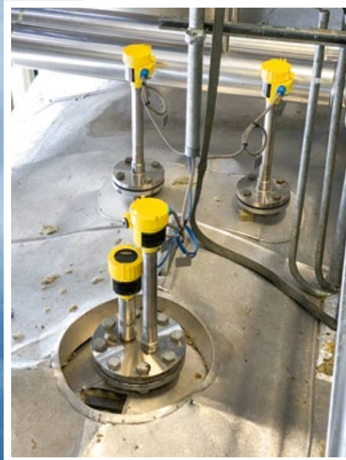
Die redundante Messung sorgt dafür, dass das Wasserniveau im optimalen Bereich arbeitet. Der Dampfessel kann somit schnell und flexibel auf die wechselnden Prozessanforderungen reagieren.
