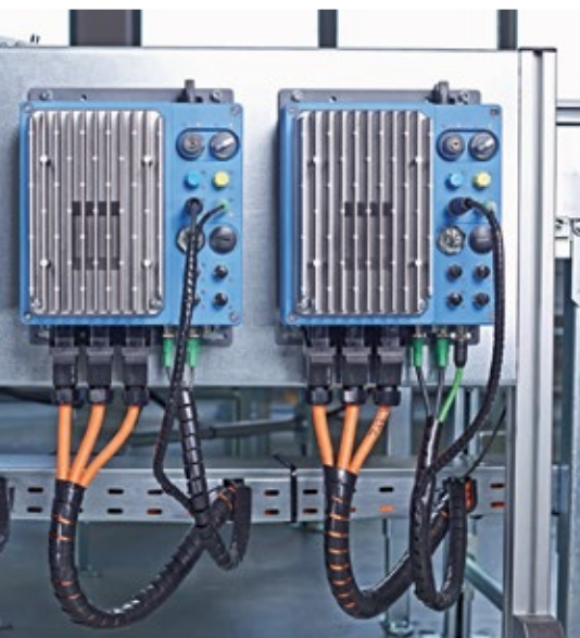
Alle Frequenzrichter von Nord verfügen über eine leistungsfähige PLC. Sie ermöglicht die Erfassung, Auswertung und Kommunikation aller Leistungsdaten – und damit Industrie-4.0-Anwendungen wie Condition Monitoring und Predictive Maintenance. Auf dem Bild: der Feldverteiler Nordac Link.
