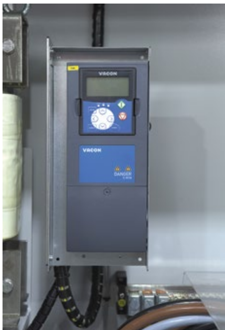
Das abgesetzt montierte Steuerteil des Vacon-NXP gibt jederzeit einen Status über das Gerät oder hilft bei Diagnose und Optimierung.
