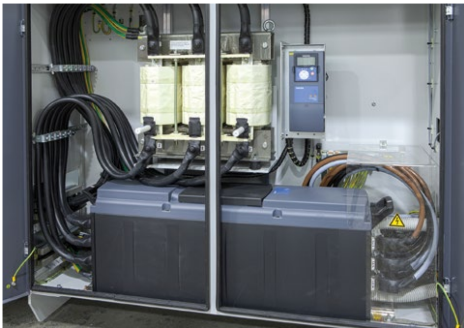
Flüssiggekühlte NXP-Frequenzrichter von Vacon bieten durch die Möglichkeit des liegenden Einbaus höchste Platzersparnis sowie eine hohe Leistung bei gleichzeitig großer Leistungsdichte. Zudem sind sie besonders geeignet für Orte, an denen eine Luftkühlung schwierig, teuer oder unmöglich ist.
