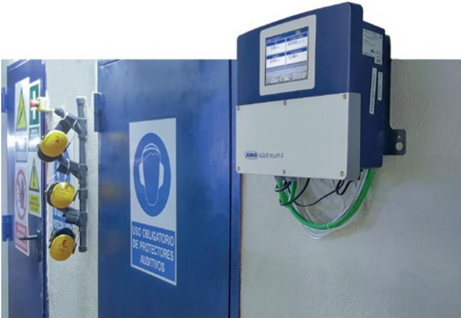
Das modulare Mehrkanalmessgerät für die Flüssigkeitsanalyse Typ 202580/202581 – Jumo Aquis touch P – ist jetzt mit DNV-GL-Zertifikat erhältlich.
