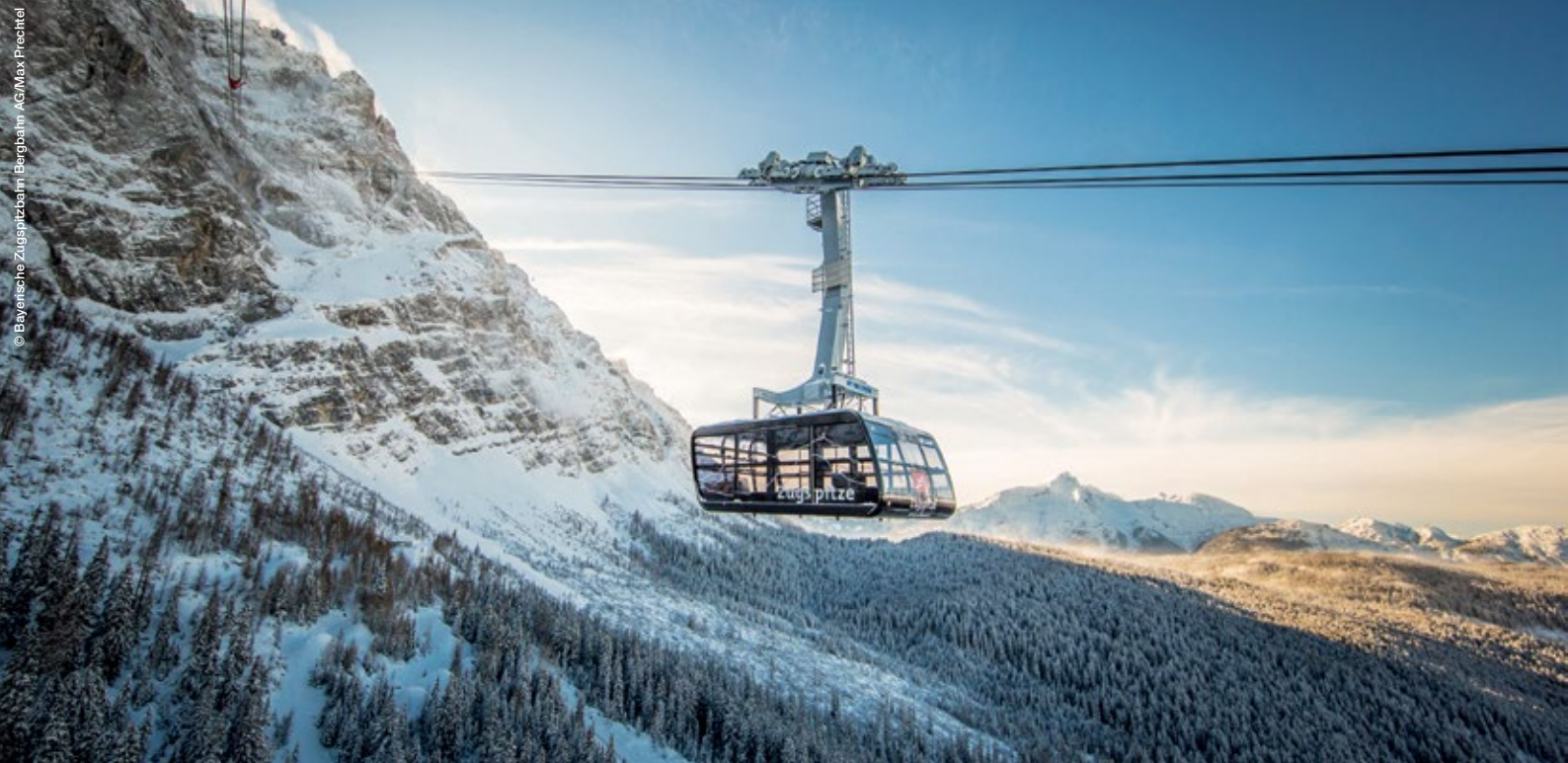
Am 21. Dezember 2017 brach die erste Gondel der neuen Seilbahn mit 120 Personen an Bord zur Bergstation der Zugspitze in 2.943,75 Meter Höhe auf.
