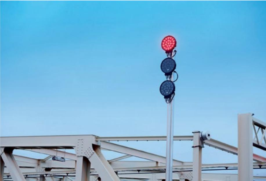
Wird die Schleusen-Signalisierung auf LED-Technik umgestellt, muss ein erneuter Nachweis der MRL-Umsetzung erbracht werden, da sich das physikalische Wirkungsprinzip von der konventionellen Lösung unterscheidet.
