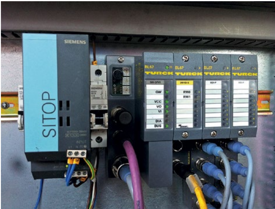
Über das BL67-System werden neben RFID-Schreibleseköpfen auch Schaltsignale angebunden.
