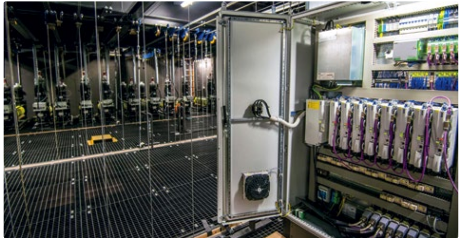
Servoregler der Lenze-Reihe 9400 treiben die Winden an, die Kulisse Teile heben und senken. Der DC-Verbund senkt den Energieverbrauch.
