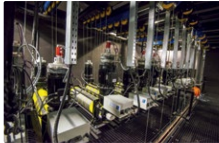
Die Schwerlastzüge auf dem Schnürboden können bis 1,5 Tonnen ziehen und werden von zwei Motoren angetrieben.
