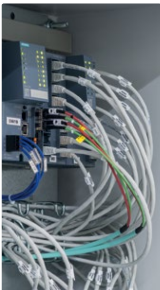
Insgesamt 95 Scalance X-Switches bilden die Schnittstellen einer Netzwerk-Struktur aus mehreren Subnetzen, zum Beispiel bestehend aus Scalance XM416-4C (l.) oder Scalance X216 (r.), die hier im Schaltschrank verbaut sind.
