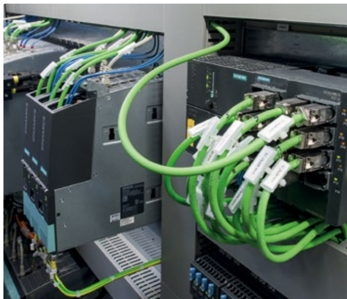
Insgesamt 95 Scalance X-Switches bilden die Schnittstellen einer Netzwerk-Struktur aus mehreren Subnetzen, zum Beispiel bestehend aus Scalance XM416-4C (l.) oder Scalance X216 (r.), die hier im Schaltschrank verbaut sind.
