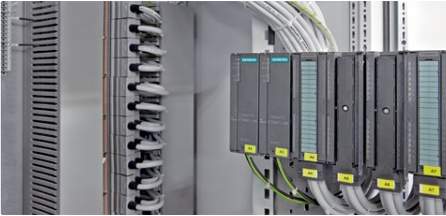
Mit den Frontadaptern der Produktfamilie VIP-Power Cabling lassen sich die 20 oder 40 Anbindungspunkte der I/O-Baugruppen einfach und schnell per Plug-and-Play-Konzept ankopeln.
