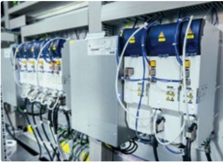
Servoregler der Reihe i700 bilden den synchronisierten Mehrachsverbund mit zentraler Einspeisung. Die Lenze Steuerung C3200 übernimmt in den Anlagen von HSM die Motion Control samt SPS. Kommuniziert wird mit Ethercat.
