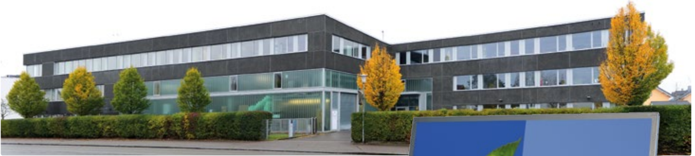
Das Firmengebäude von Data Display in Germering bei München
