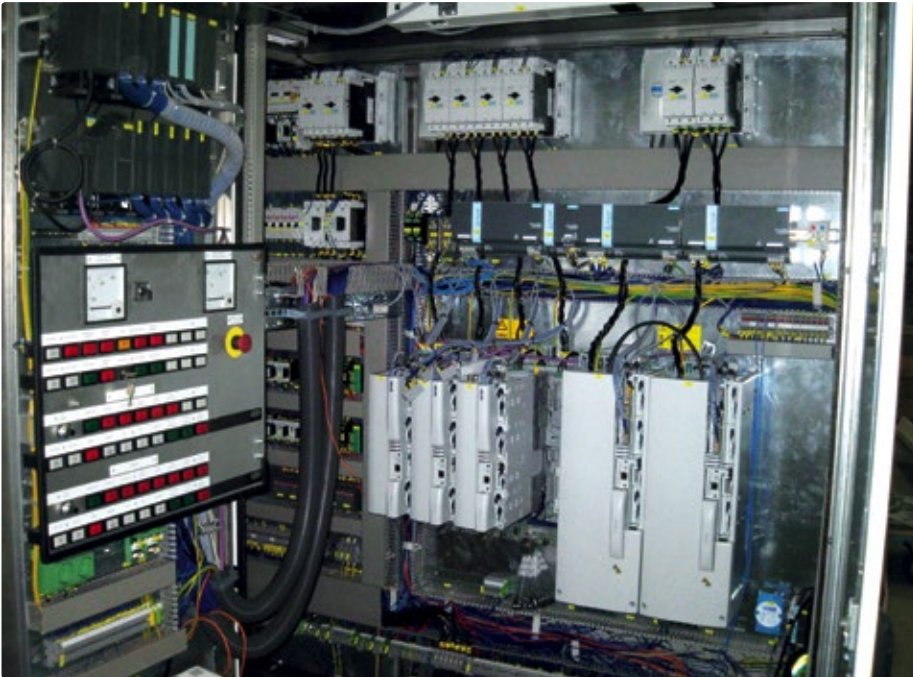
Der Schaltschrank steht auf der Antenne im Freien und ist Wind und Temperatur ausgesetzt. Alle Komponenten im Schrank sind auf geringe EMV-Abstrahlung ausgelegt worden, sodass der Empfang der Signale aus dem Weltall nicht beeinträchtigt wird.
