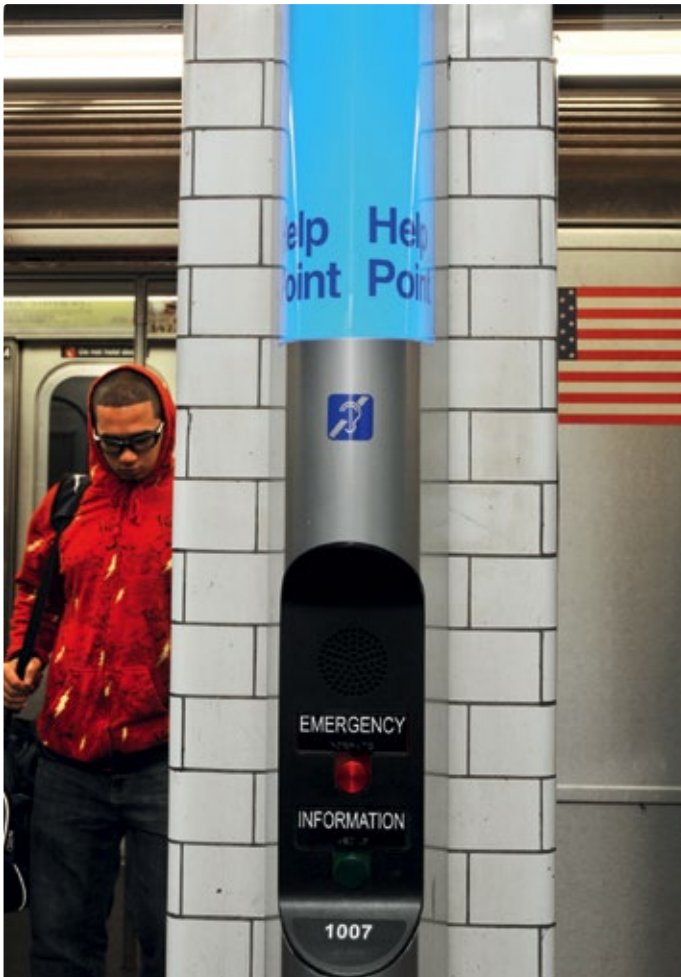
An den Help Points in der New Yorker U-Bahn sind Harting-PushPull-Signalsteckverbinder in 10-poliger Ausführung verbaut.
