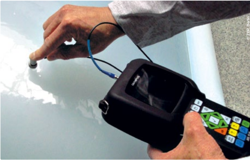
Die Kontrolle mit dem Ultraschallschichtdicken-Messgerät 38DLPlus von Olympus belegt, dass eine Lichtkuppel durchsturzsicher gemacht wurde.
