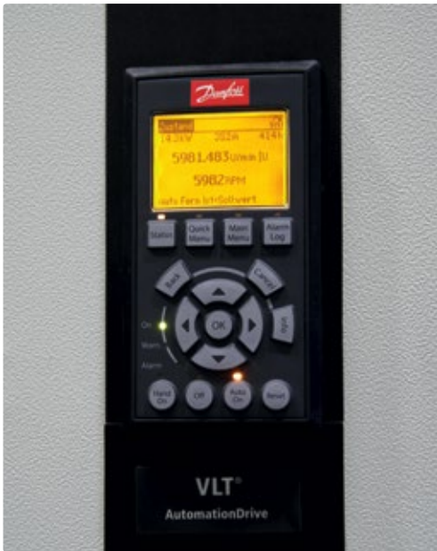
Das grafische Display gibt während der Tests Aufschluss über die aktuellen Werte. Alle Werte laufen aber auch in der Steuerwarte zusammen, wo das System sie automatisch protokolliert.
