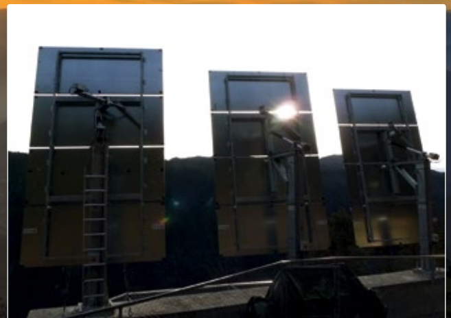
Computergesteuert lenken die drei Heliostaten mit einer Gesamtfläche von 51 Quadratmetern das Sonnenlicht ins Stadtzentrum.
