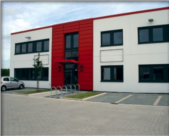
Vorausgedacht: Falls die neu geschaffenen Produktions- und Büroflächen von rund 2.900 Quadratmetern nicht ausreichen sollten, hat Rollon die Option, die benachbarten Gebäude in fünf Jahren ebenfalls anzumieten.
