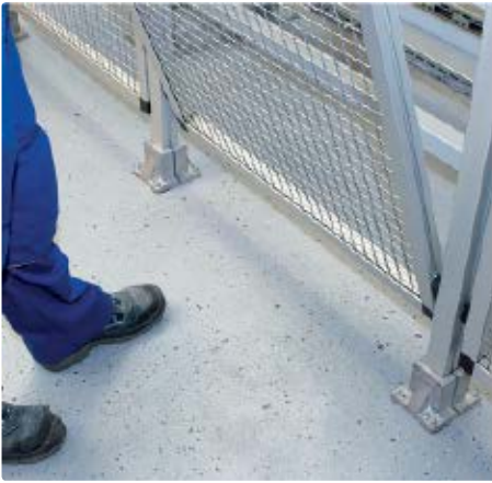
Einfache und schnelle Montage: Rahmen in die untere Halterung stecken, leicht anheben und in die obere Halterung drücken – fertig!
