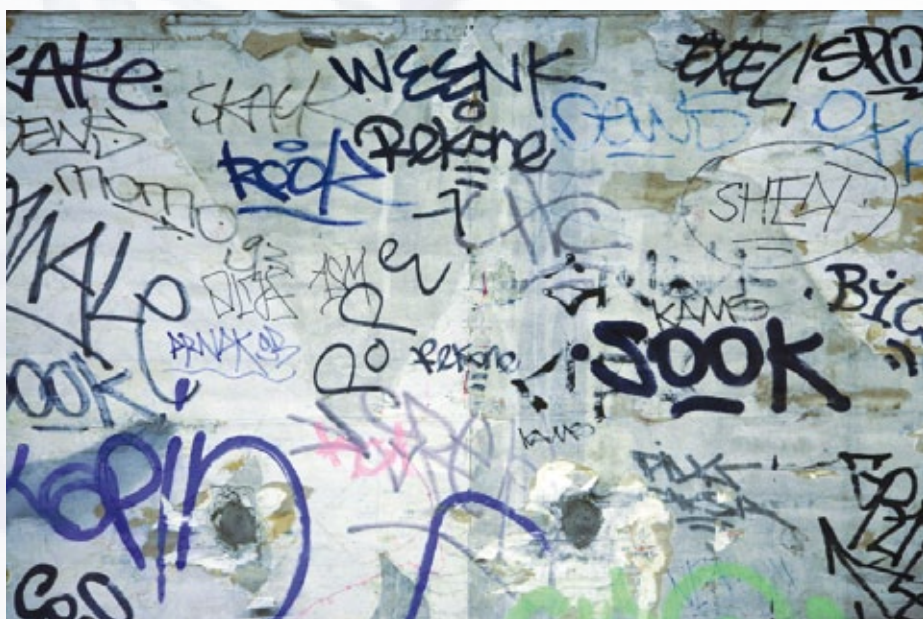
Ein auf individuelle Anforderungen abgestimmtes Sicherheitskonzept bietet Schulen vielfältigen Schutz vor Gefahren wie Vandalismus, Gewalt, Diebstahl oder Brandstiftung.
