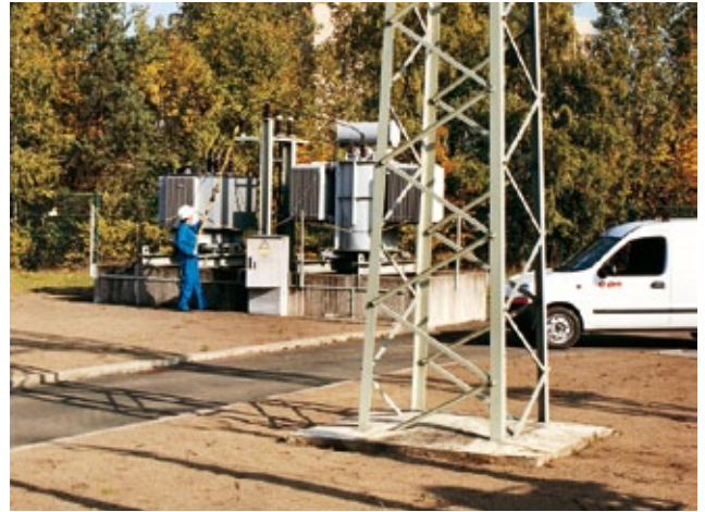
Bosch stattet die Firmenzentrale von E.ON Bayern mit leistungsstarken Sicherheitstechnologien aus.
