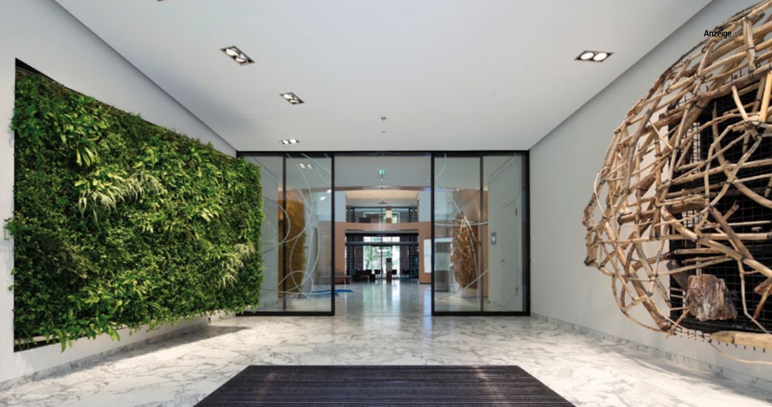
Windfang und Eingangsbereich der Ethianum Klinik in Heidelberg: Linearschiebetüren im Flucht- und Rettungsweg mit „Slimdrive SL NT-FR“ Antriebssystemen
