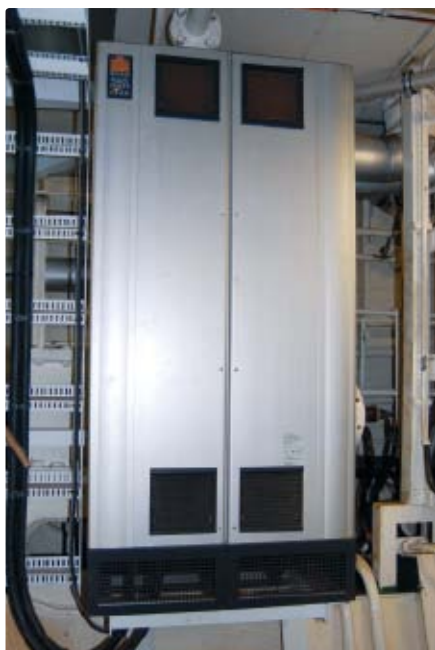
Zwei 190 A VLT-Advanced-Active-Filter AAF 006 stellen sicher, dass die Verzerrung der Spannung unter acht Prozent THD v liegt – auch wenn alle Systeme gleichzeitig mit voller Leistung laufen.
