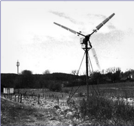
Gesamtanlage mit dreiflügeligen Schnellläufer, Klimamast und Messhaus
