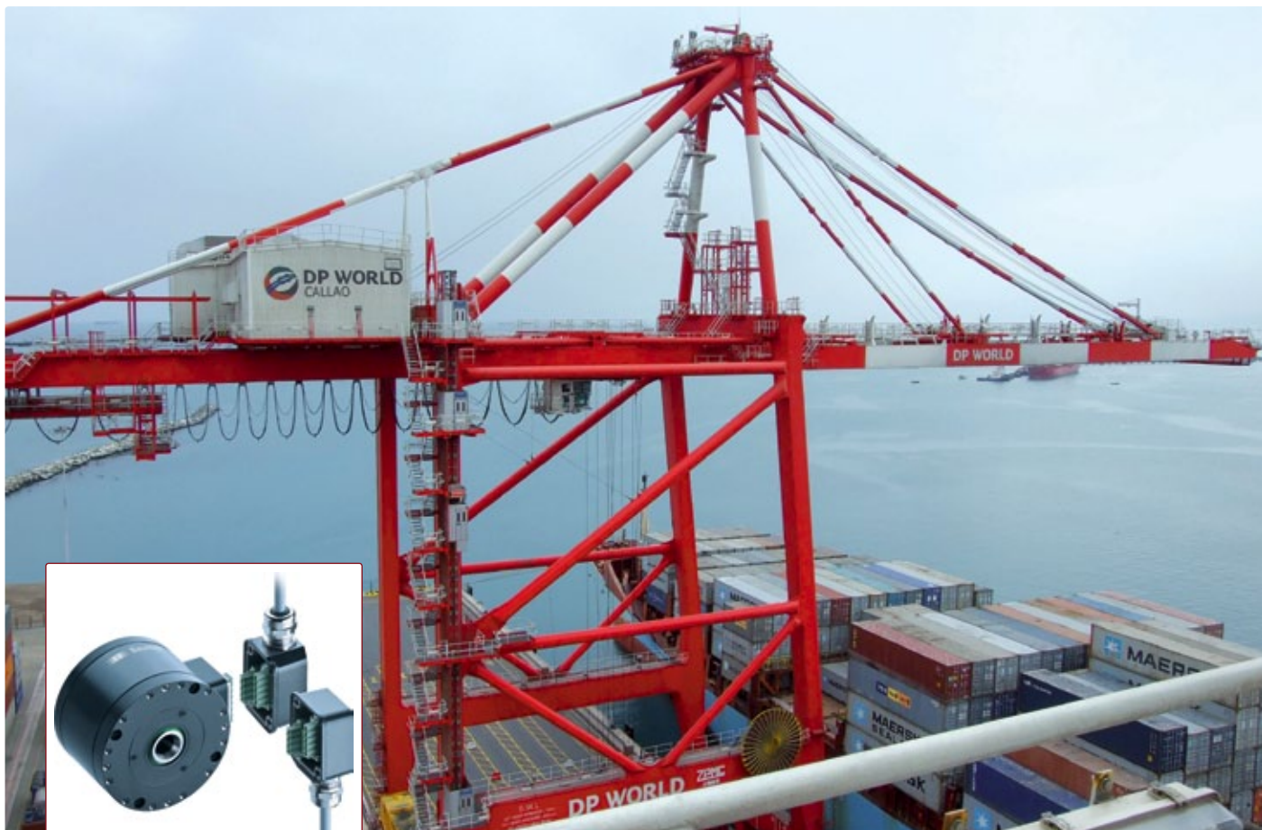
Drehgeber, die in Kränen in Seehäfen verbaut sind, wird viel abverlangt – sie sind rund um die Uhr im Einsatz und ständiger Korrosion durch feuchte, salzhaltige Seeluft ausgesetzt.
