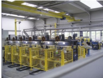
Abb. 5: Maschinelles Drahtziehen ist ohne leistungsfähige Regelungstechnik nicht zu realisieren.
