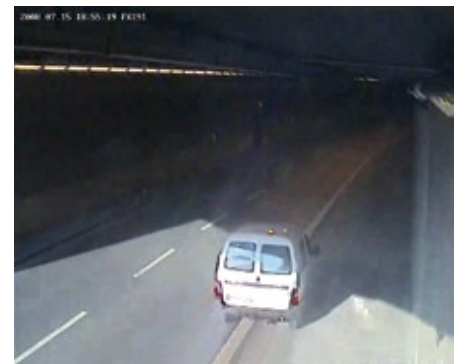
Abb. 2: Unregelmäßigkeiten erkennt das System sofort – selbst unter ungünstigen Lichtbedingungen.
