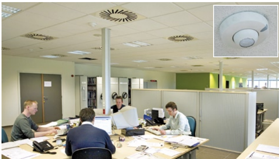
Abb. 1: Wenn der Bewegungsmelder registriert, dass sich niemand im Büro befindet, sendet er ein Funksignal an den Empfänger, der das Licht ausschaltet
