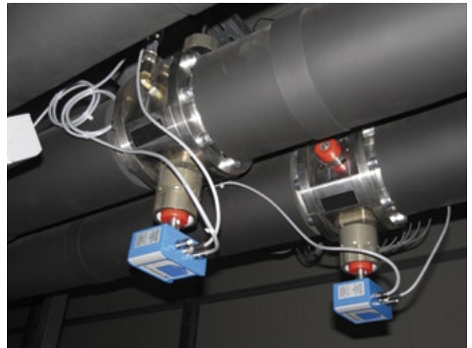
Abb.: MultiController standard 201i bei 40 bar(ü) im Einsatz beim Kunden (Druck, Volumenstrom, Temperatur und Feuchte werden parallel an einer Messstelle erfasst).
