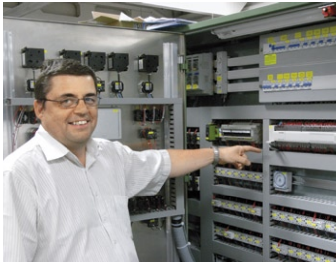
Abb. 1: Elektroanlagen von Schubert gehen in die ganze Welt. Hier zeigt Fertigungsleiter Ing. Manfred Bandion Teile eines Verteilers für eine Wasserversorgungsanlage.
