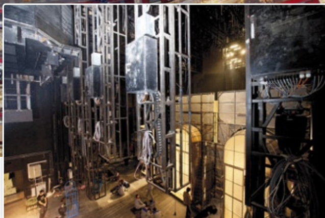
Die teleskopierbaren Seitenlichter können sowohl vertikal als auch horizontal verfahren werden.
