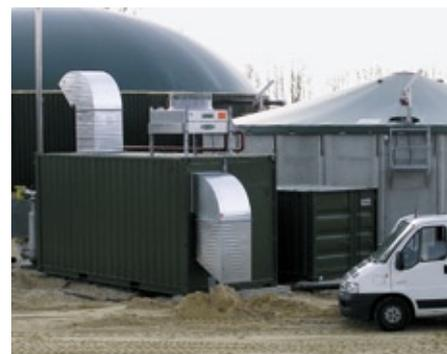
▲ Im Blockheizkraftwerk der 500-Kilowatt-Biogasanlage im Landkreis Lüchow-Dannenberg erzeugen zwei Gasmotoren mit Generator den Strom.
