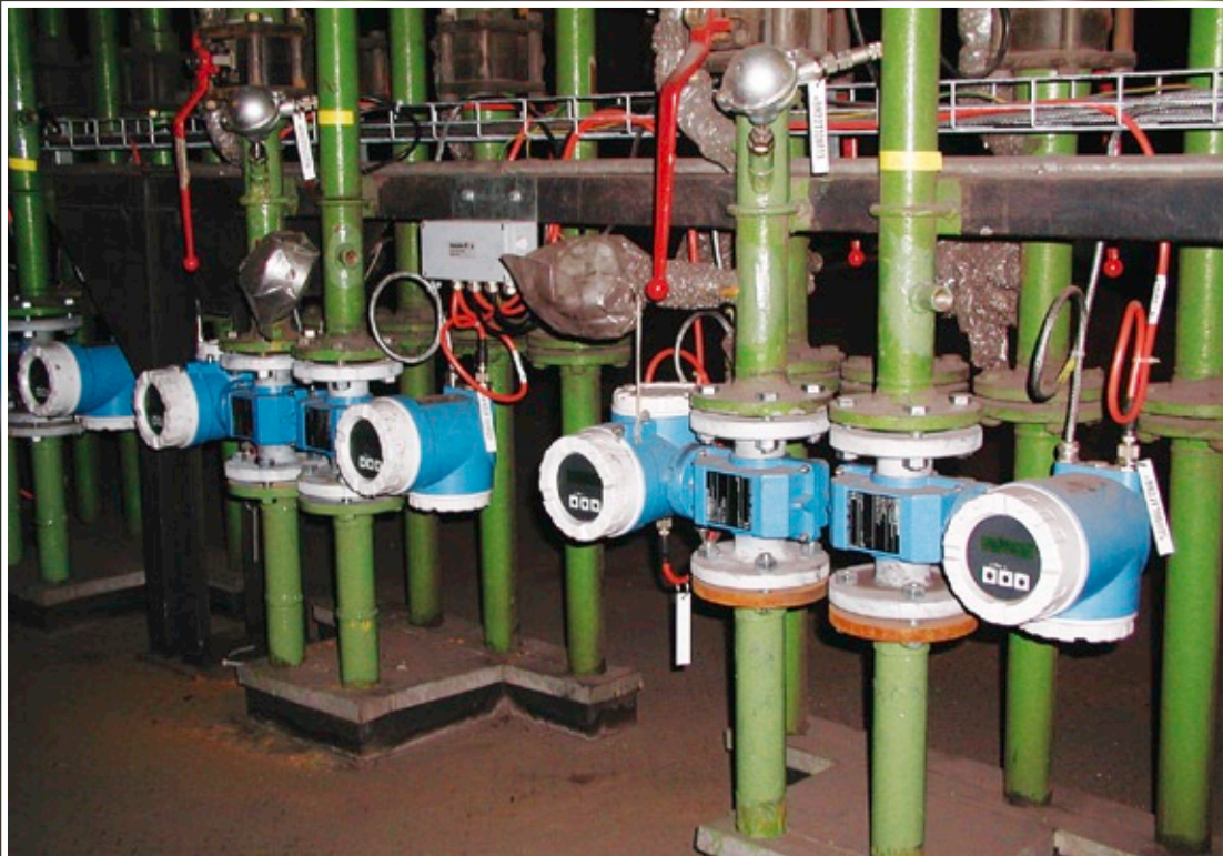
Abb. 1: Leckageüberwachung am Hochofen mit den magnetisch-induktiven Durchflussmessgeräten Promag
