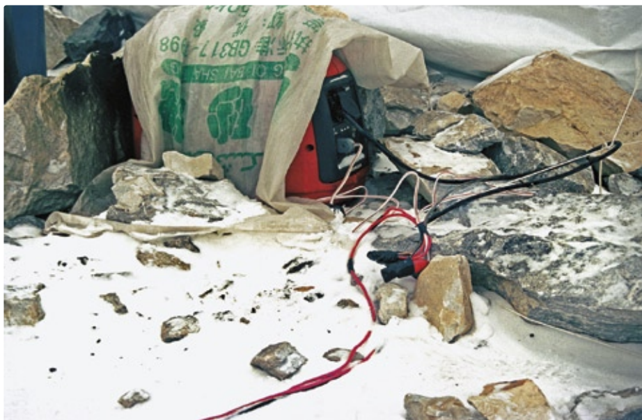
Der Generator des Lagers. Das Ölflex-Kabel Heat 180 EWKF ist gut zu erkennen. Foto: Lapp Polen
