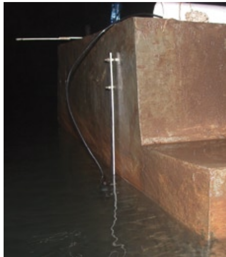
Abb. 2: Der Pegelstand des bis zu 2 m hohen Unterwassers wird von einem Drucklogger gemessen. (Foto: KIT)
