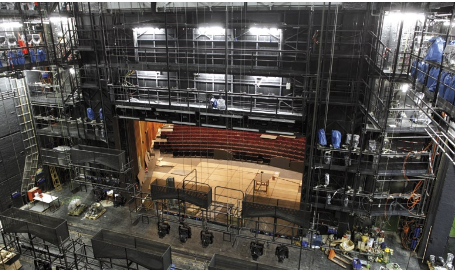
Das Schillertheater Berlin, Blick aus der Arbeitsgalerie beim Umbau Foto: Thomas Bartilla
