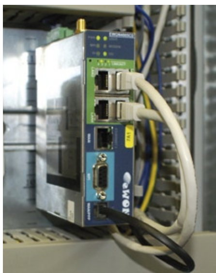
Das kompakte Fernwirkmodul eWON findet in jeder Verteilung Platz und kann unterschiedliche Medien zur Anbindung von Anlagen an das Internet nutzen.
