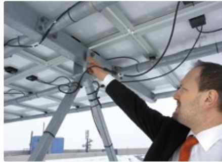
Robuste, schmier- und wartungsfreie Kunststoff-Gleitlager Igus sichern die Kippbewegung des Nachführsystems. (Quelle: igus GmbH, Köln)
