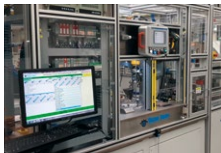
Vision Stone hat ein auf das Unternehmen TRW zugeschnittenes automatisiertes Kontrollsystem entwickelt und installiert, dessen Herzstück mehrere Smart-Kameras von Microscan bilden.
