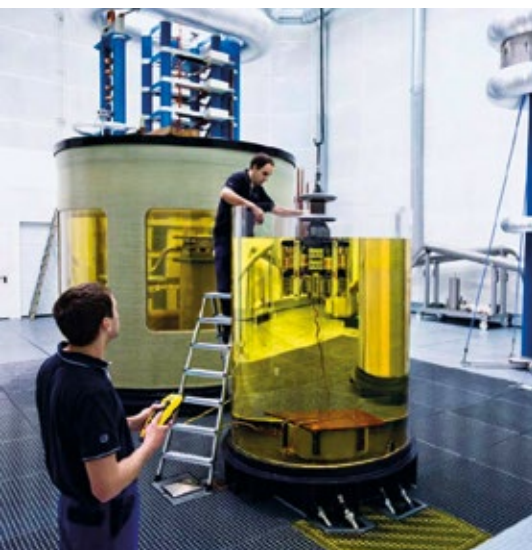
Halle für Hochspannungsprüfungen im Versuchszentrum Regensburg der Maschinenfabrik Reinhausen: Herunterlassen eines Prüflings in den mit Öl gefüllten Prüfbehälter
