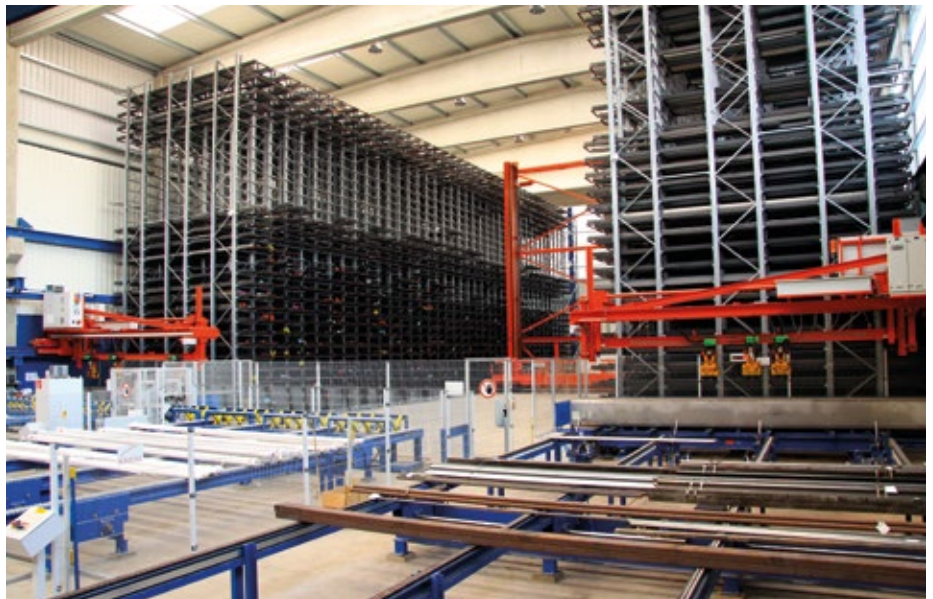
Highlight der Videosicherheitslösung von Mobotix beim Stahlproduzent Bieber + Marburg in Gießen: Zwei Kameras sind auf einem Kran befestigt in etwa 12 m Höhe und inspizieren das Hochregallager. Manche Bereiche waren vorher schwer oder kaum einsehbar. Jetzt weiß die Disposition jederzeit sofort Bescheid, wenn es zu Störungen kommt.
