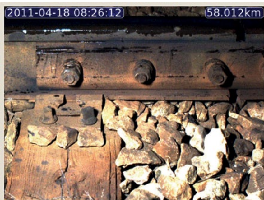
Aufnahme des Gleisbetts mit der Basler Scout.
