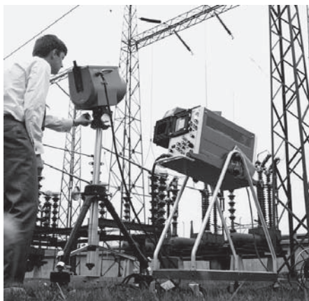
Thermovision 661 bei der Inspektion einer Umspannstation im Jahr 1969
