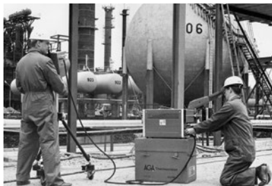
Abb. 3: Inspektion von petrochemischen Tanks
