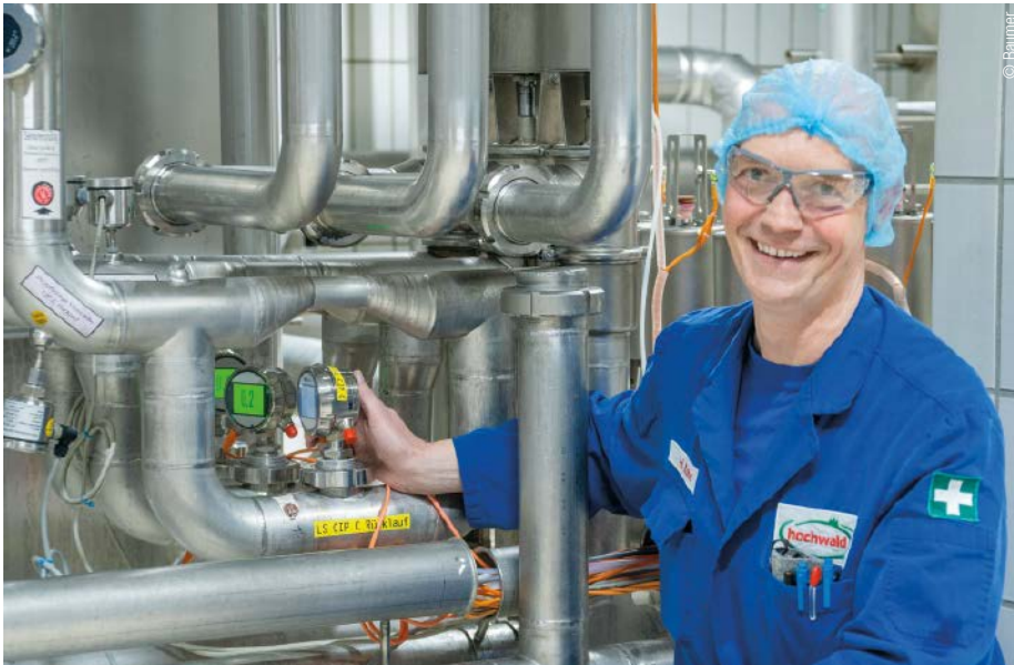
Der Elektrotechnische Leiter Holger Kuhn setzt bei der Leitfähigkeitsmessung auf den Baumer-Sensor AFI 4.
